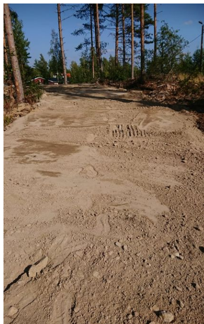
Nytt bärlager / material utlagt.
