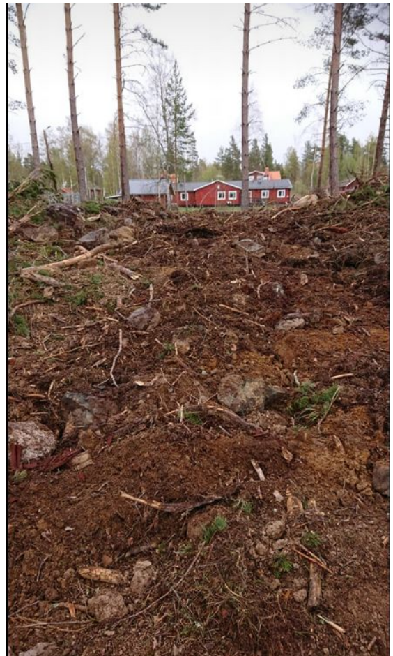
En del av slingan där markarbetena är i ett tidigt skede..
